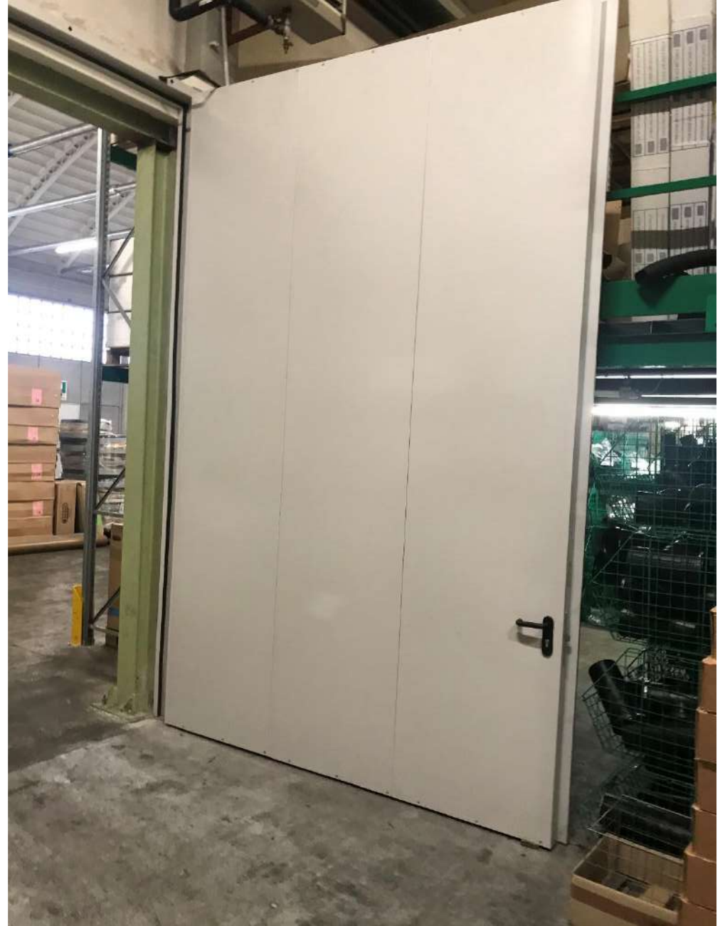
PORTONI APRIBILI A VOLATA AD ANTA SINGOLA OMOLOGATI TGF EI-120 serie MAGNUM (LxH 3000 x 3350 esclusivamente per grandi dimensioni - auto/chiusura tramite elettromagnete)
