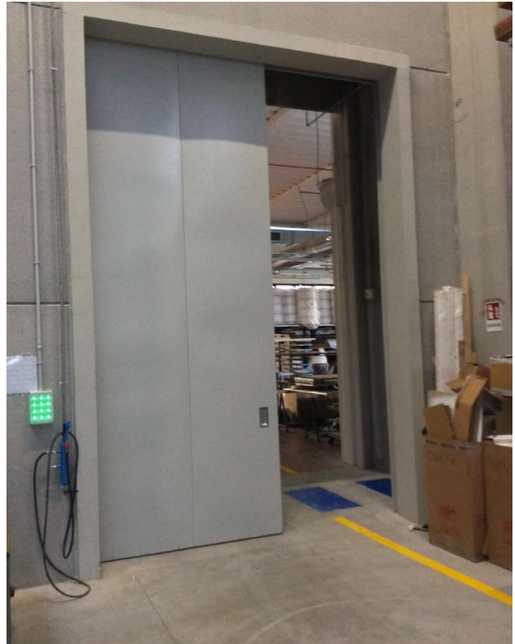
TAGIAFUOCO SCORREVOLI EI-120 - ACCESSO PEDONALE O CON CARRELLI /TRANSPALLET - UNI-EN 16341-1 con marcatura CE
