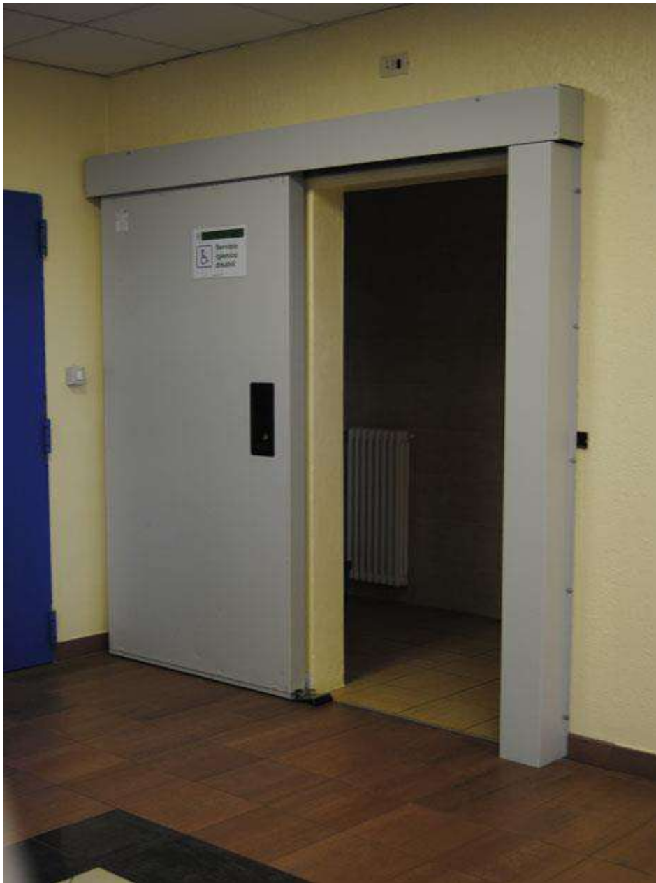
TAGIAFUOCO SCORREVOLI EI-120 - ACCESSO PEDONALE O CON CARRELLI /TRANSPALLET - UNI-EN 16341-1 con marcatura CE
