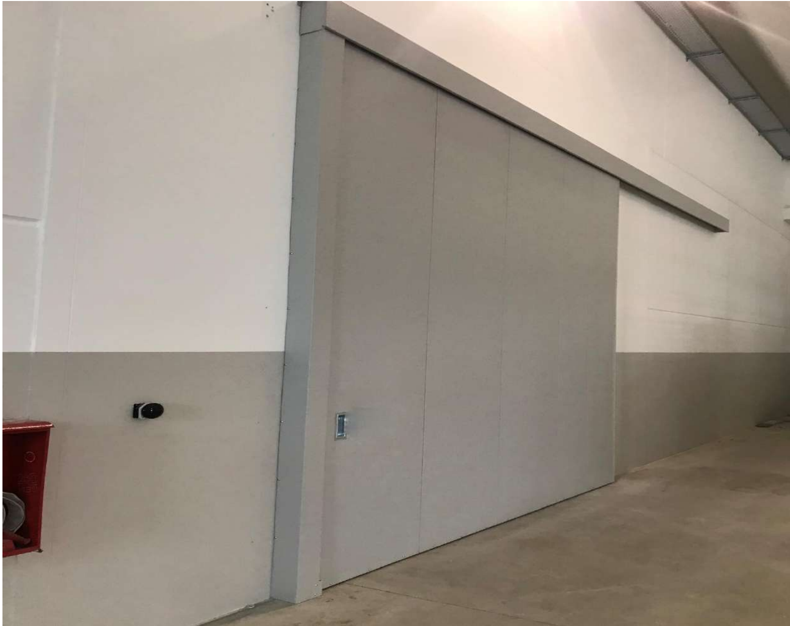
PORTONE SCORREVOLE TAGLIAFUOCO AD ANTA SINGOLA EI-120 CE (compartmentazione da zona produzione a zona stoccaggio materia prima di opificio industriale)
