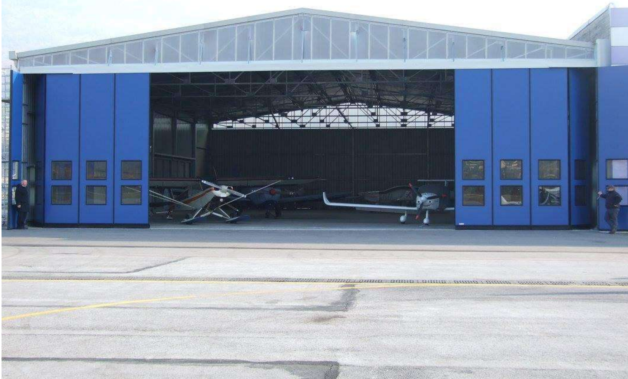
8+8 ANTE MONTAGGIO A SCORRETE SUI LATI INTERNI, CON PANNELLO LATERALE A RIBALTAMENTO ESTERNO 180°
