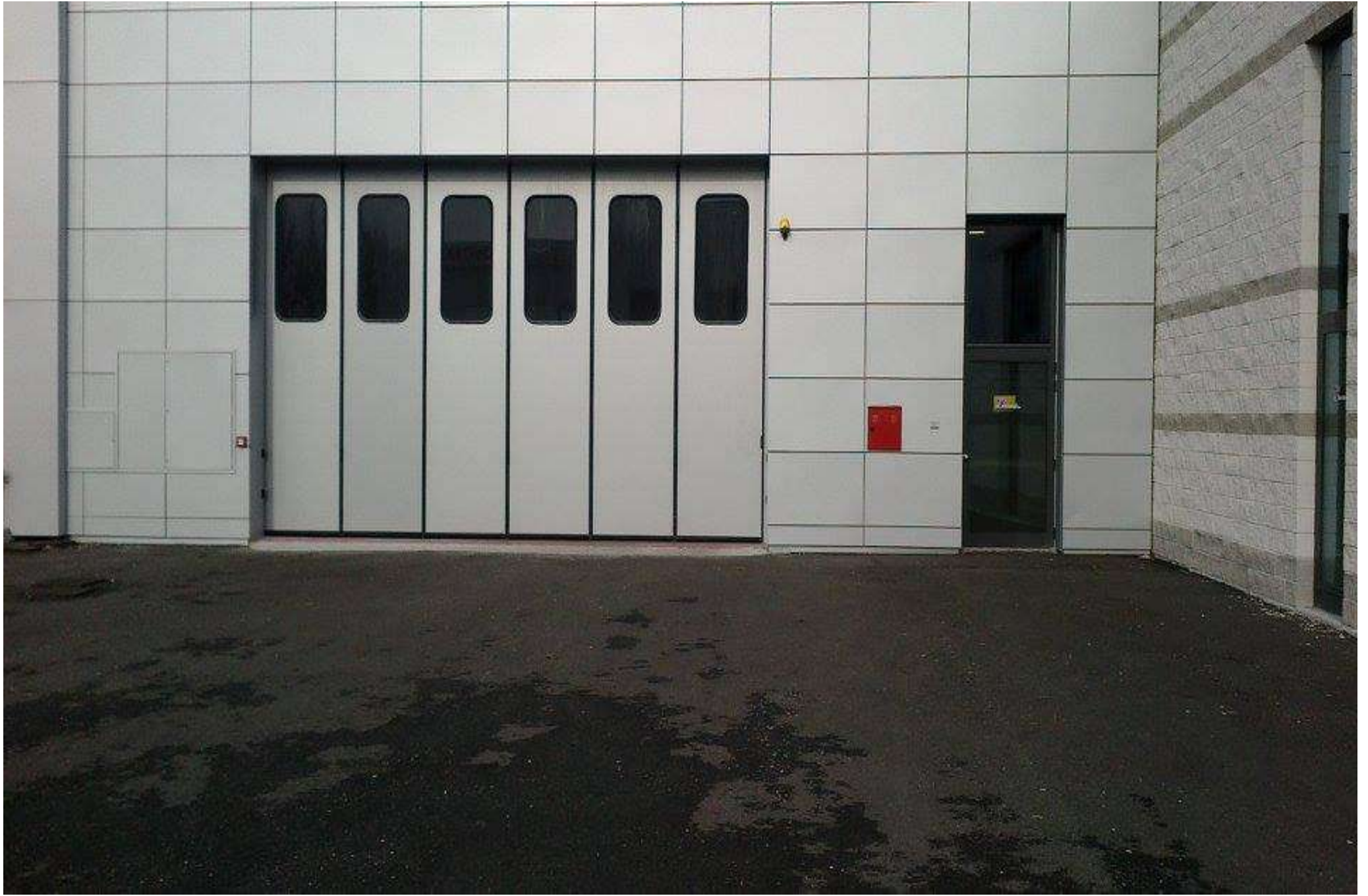
PORTONE INDUSTRIALE 6+0 ANTE MOTORIZZATO 400V. E GUIDA INCASSATA A PAVIMENTO
