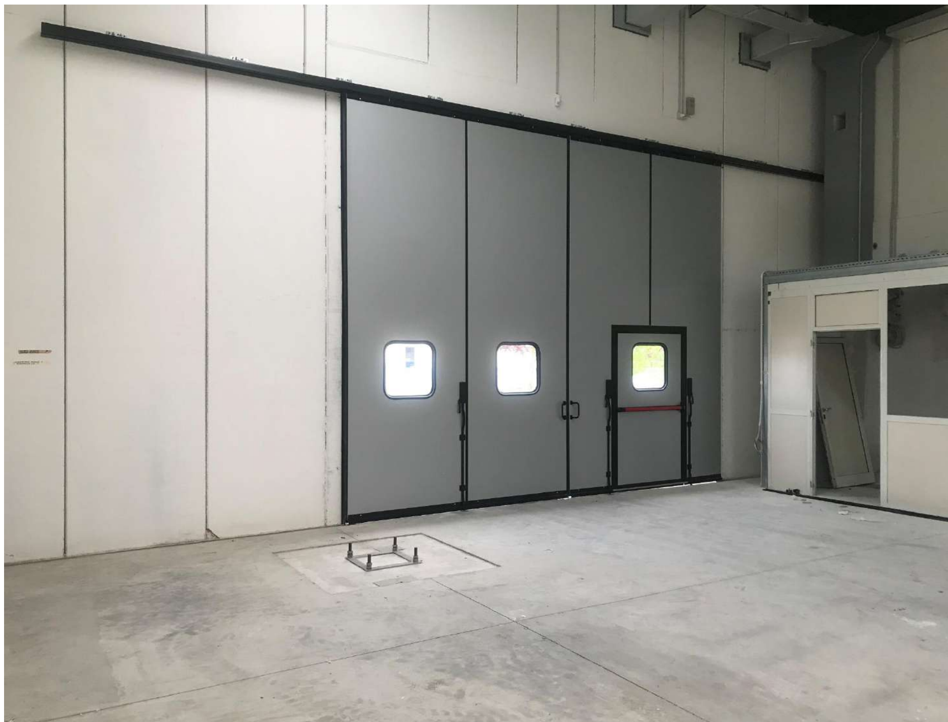
PORTONE SCORREVOLE INTERNO A 2 ANTE CONTRAPPOSTE (senza guida a terra) + PORTA PEDONALE Via Fuga
