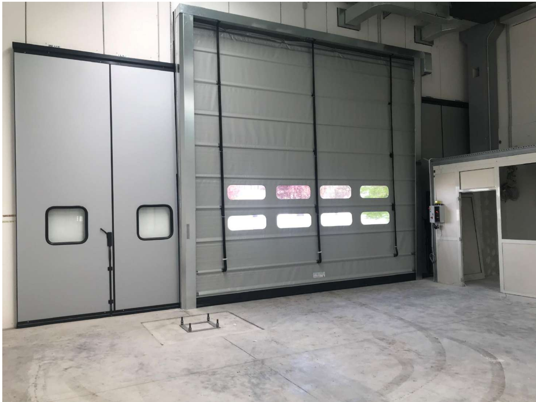
PORTONE SCORREVOLE A DUE PARTITE INTERNO + PORTA AD APERTURA RAPIDA (complesivo ancorato all'interno)
