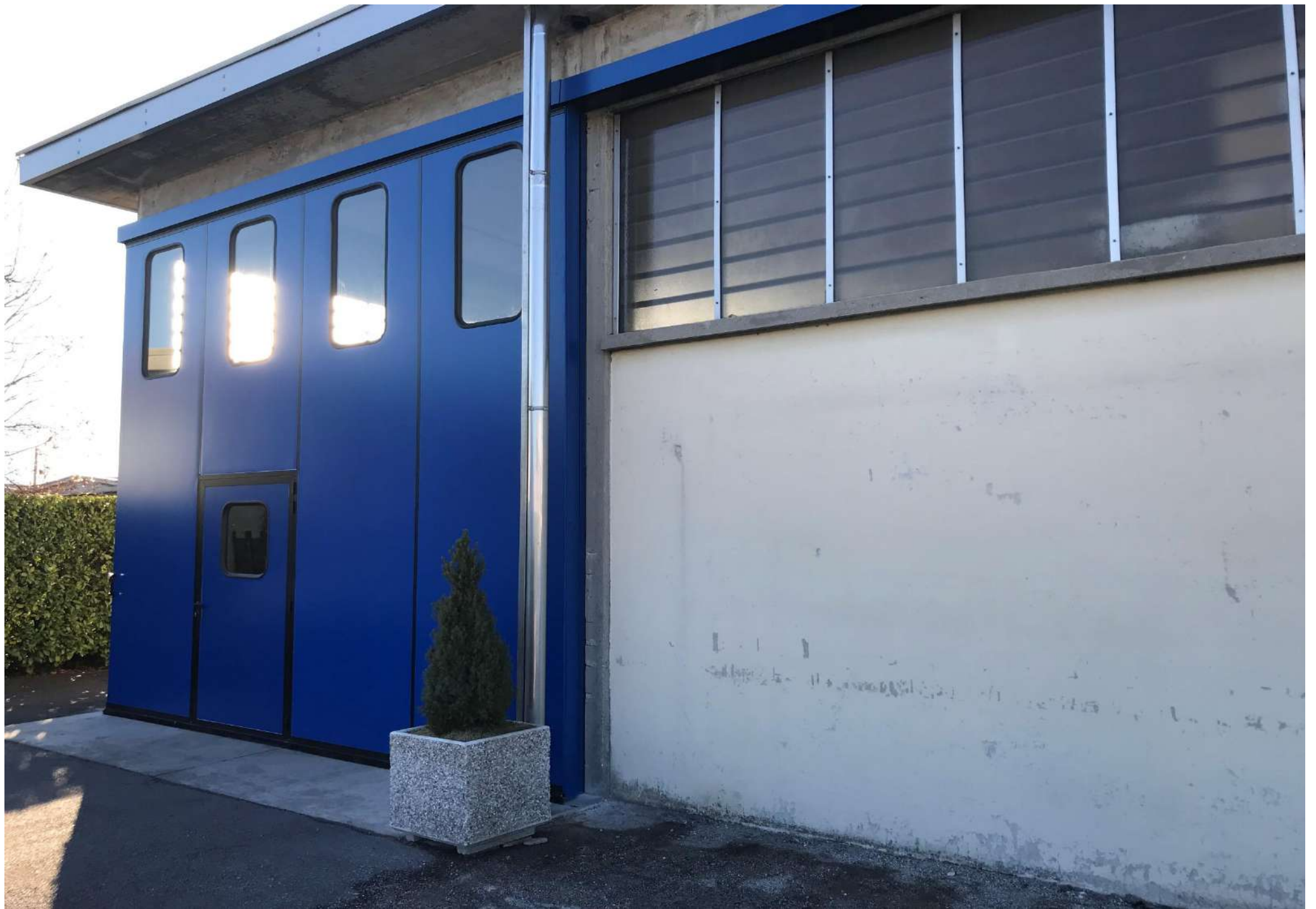
SCORREVOLE ESTERNO CON PORTA VIA FUGA SENZA INCIAMPO INFERIORE & COVER COPRIGUIDA SUPERIORE
