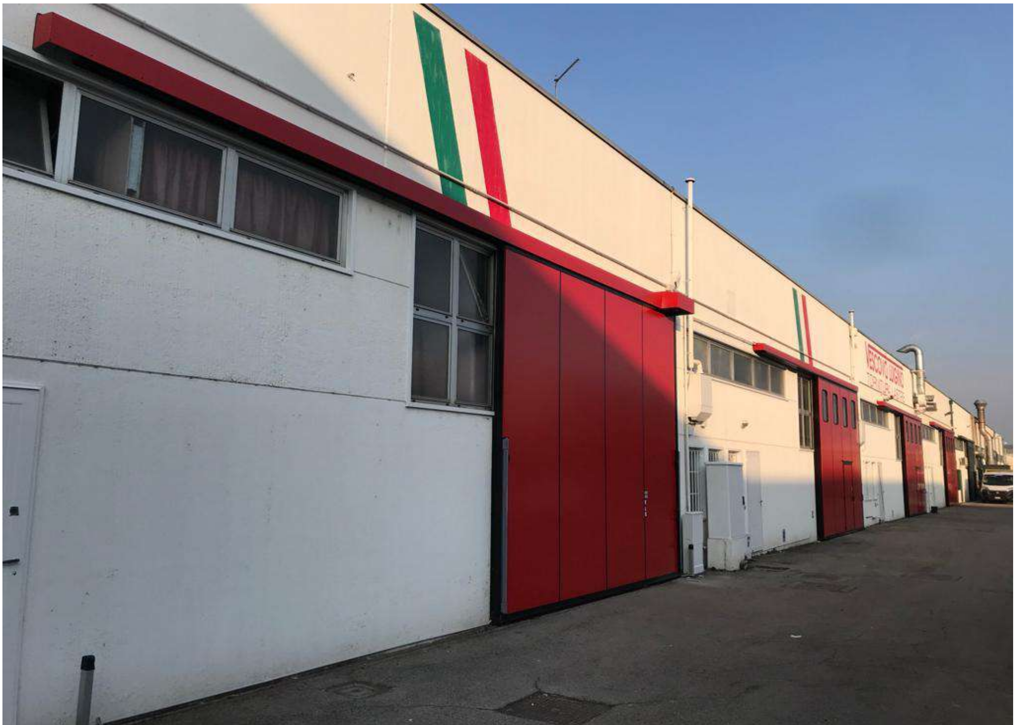
SCORREVOLI ESTERNI IN SOSTITUZIONE CON PORTA PEDONALE
