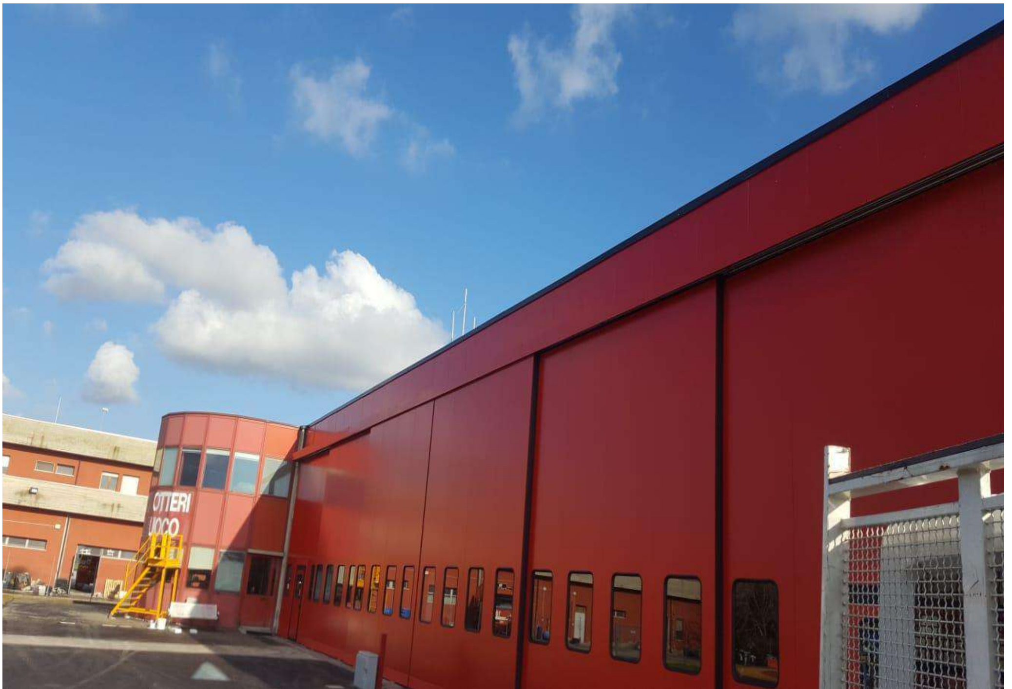
SCORREVOLI AD ANTE SOVRAPPOSTE PER CHIUSURA IN SICUREZZA DI GRANDI FORI
