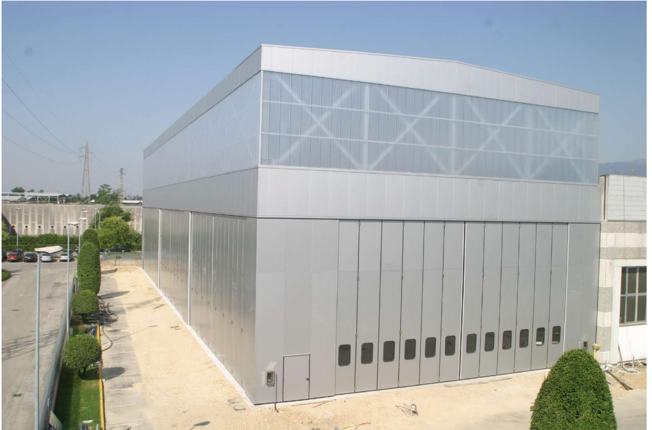
PORTONE MULTI-ANTA FINESTRATO MEGA-DOOR + PORTA VIA FUGA LATERALE
