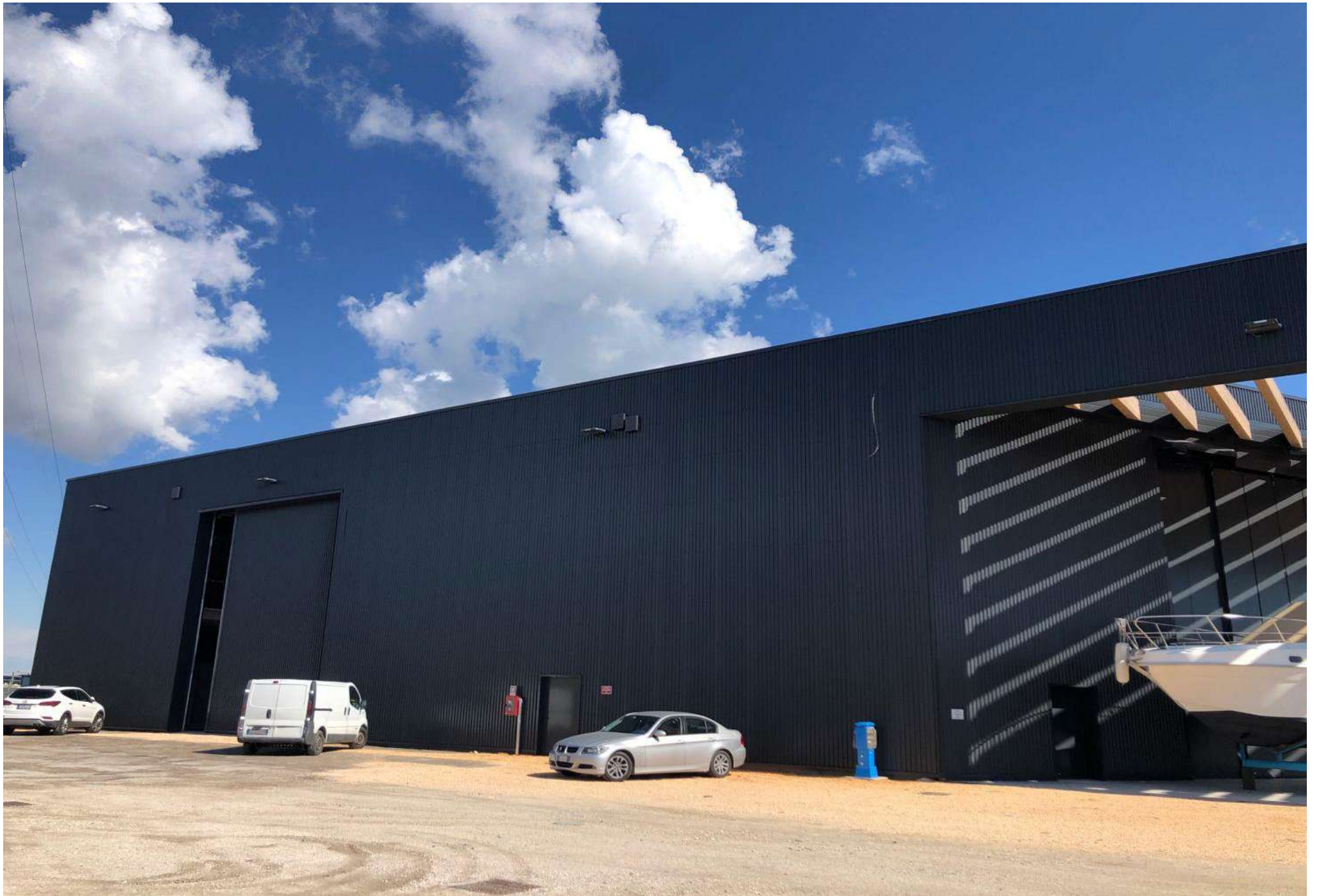
SCORREVOLI INTERNI & ESTERNI COLORE A CAMPIONE ANTRACITE SU CANTIERE NAUTICO
