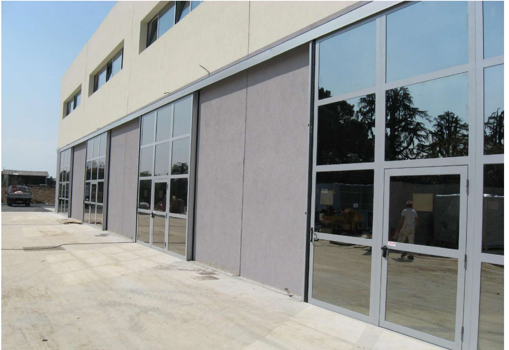
PORTONI SCORREVOLI ESTERNI FINISTRATI ( struttura da profili in alluminio ) CON VETRATURE STOP-SOL + PORTA VIA FUGA
