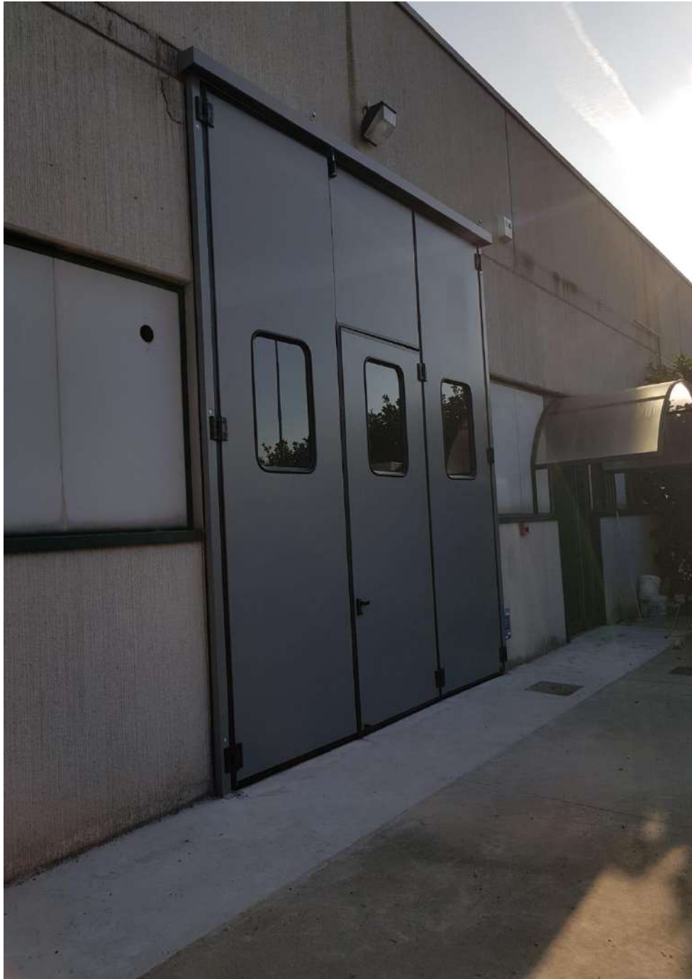
2+1 ANTA CON PORTA CENTRALE VIA DI FUGA MONTAGGIO ESTERNO
