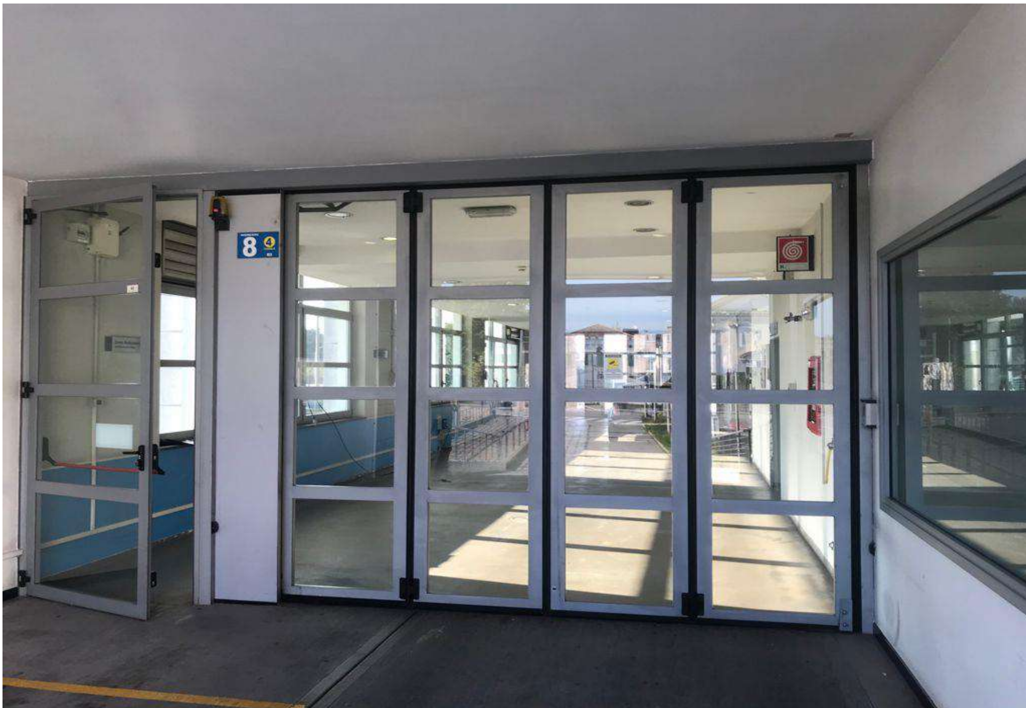
2+2 ANTE COMPLETAMENTE FINISTRATO (5+5 visarm trasparente) CON PORTA VIA FUGA LATERALE
