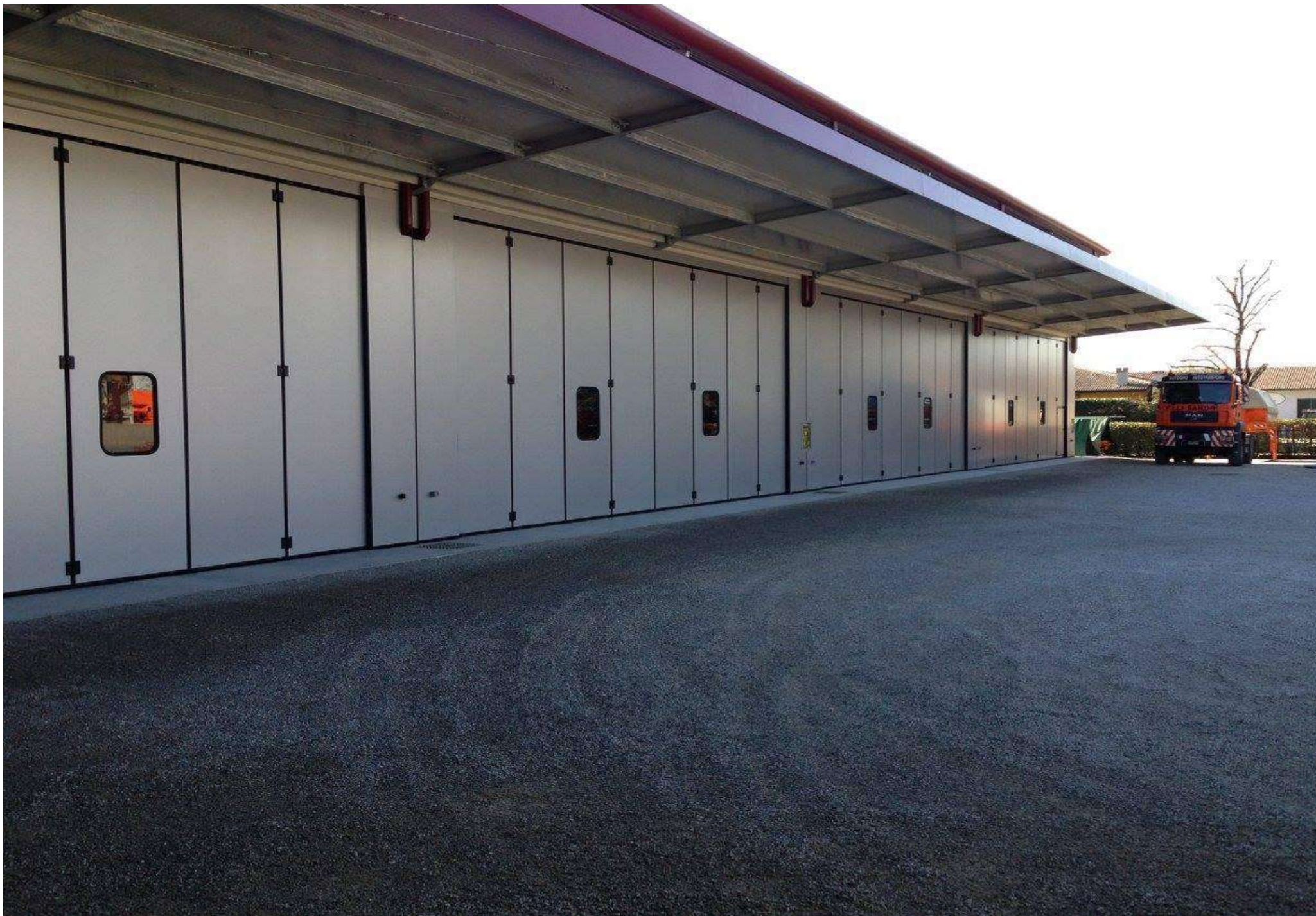
FRONTE CONTINUO DI PORTONI 4+4 ANTE MOTORIZZATI IN BATTERIA SENZA GUIDA A TERRA & PANNELLI COPRI-IMPACCO
