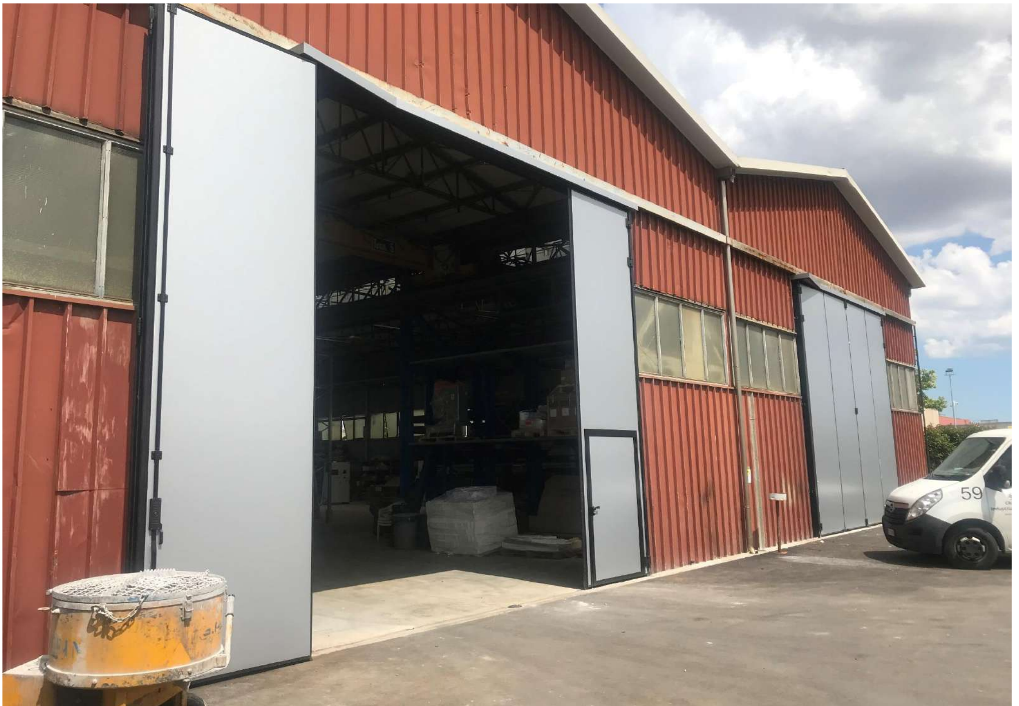
PORTONI A LIBRO (sostituzione vecchi scorrevoli in lamiera grecata), MONTAGGIO in ESTERNI 3+1 ANTE + RIBATAMENTO PACCO ANTE a 180° + PORTA VIA FUGA SENZA INCIAMPO A TERRA "H. 6200 mm"
