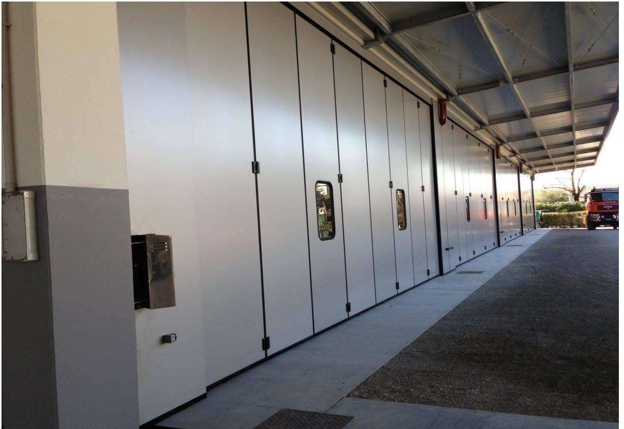
PORTONI MULTIANTA A LIBRO IN BATTERIA+PANNELLI FISSI MASCHERAMENTO IMPACCHI ANTE
