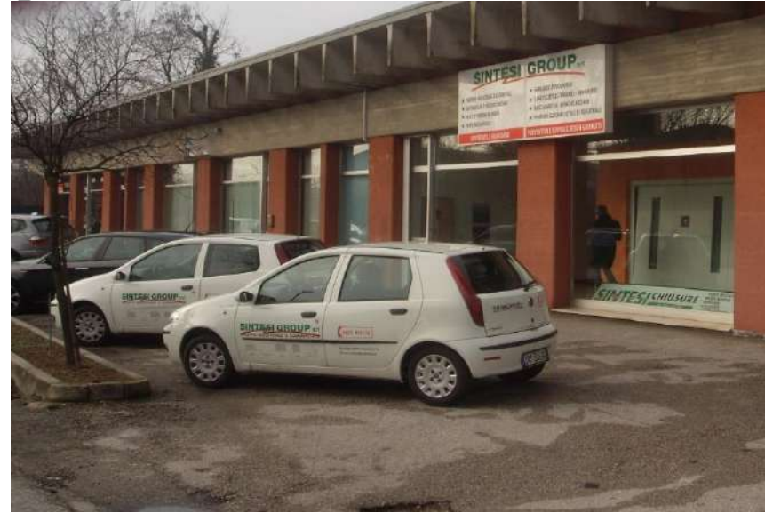
TV PAESE - UFFICI COMMERCIALI; MOSTRA PRODOTTI; MAGAZZINI
