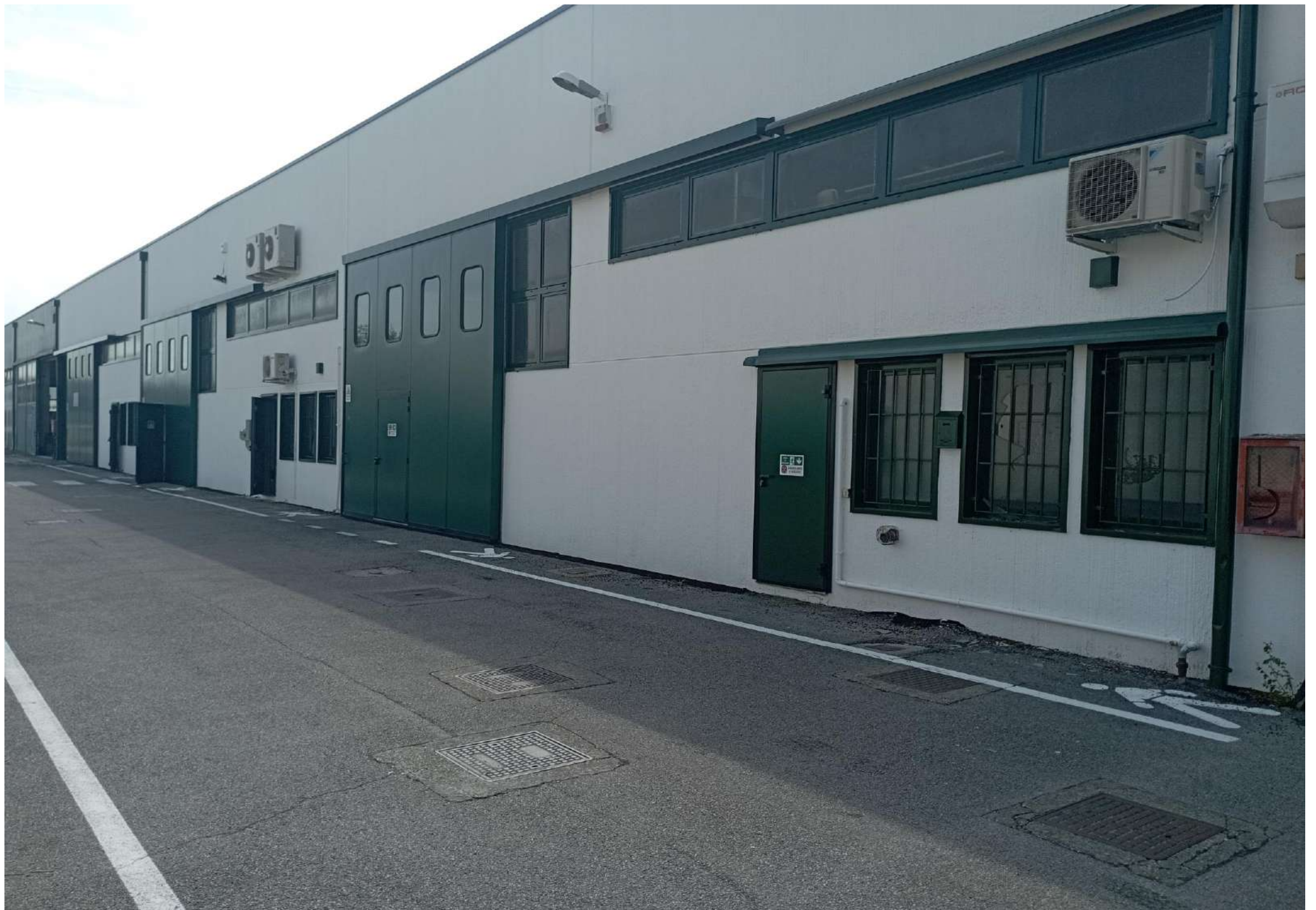
SCORREVOLI ESTERNI CON VETRATURE & PORTE VIA FUGA SENZA TRAVERSA INFERIORE + PORTE AD ANTA SU ACCESSI DIVERSI
