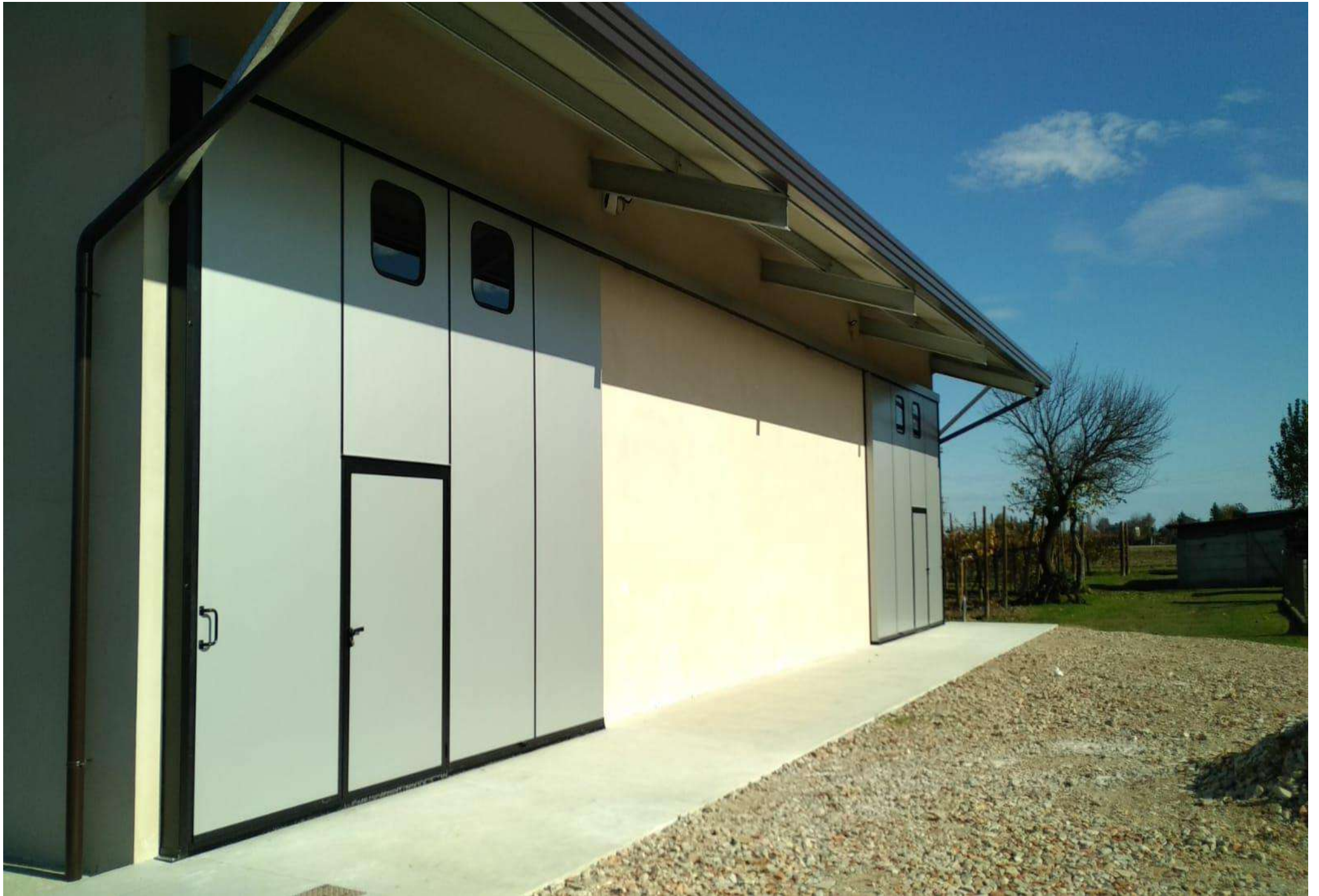
SCORREVOLI ESTERNI CON PORTA VIA ESODO SU OPIFICIO AGRICOLO
