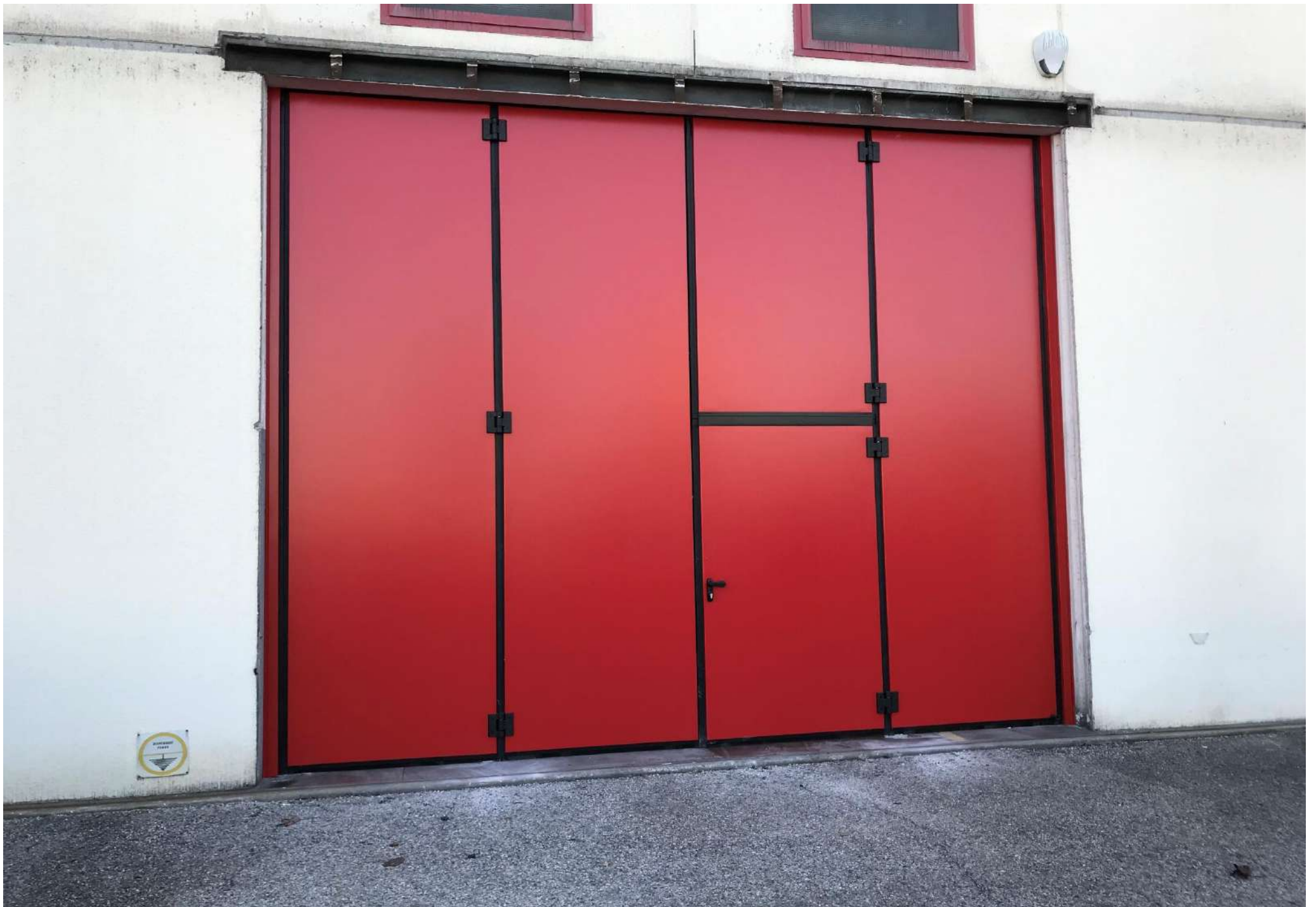
2+2 ANTE CON PORTA PEDONALE MONTAGGIO PARZIALMENTE IN LUCE (sostituzione di precedente scorrevole esterno)
