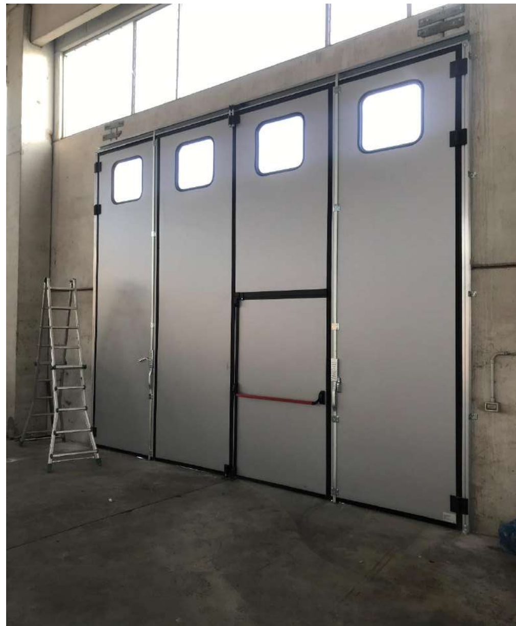
PORTONE 2+2 ANTE CON VIA FUGA INTEGRATA (vista interna)
