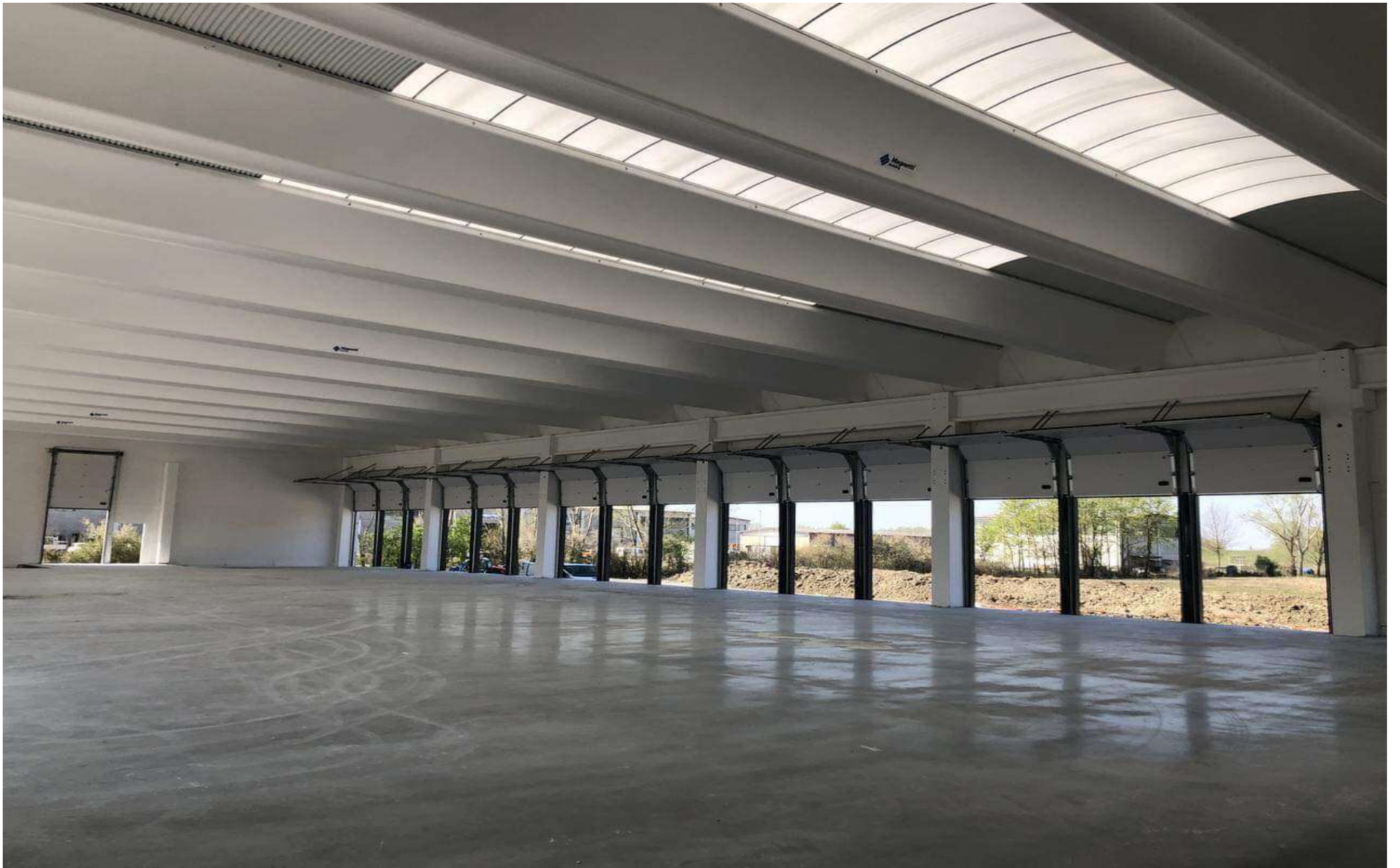
PORTONI SEZIONALI IN BATTERIA SU PUNTI DI CARICO A RIBALTA ESTERNI
