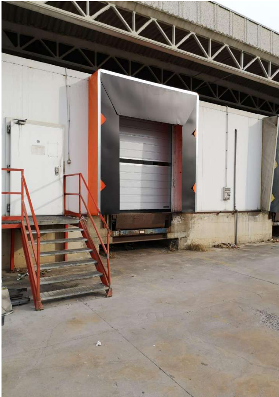
MANUTENZIONI/SOSTITUZIONI SU BAJE DI CARICO DI PORTALI ISOTERMICI
